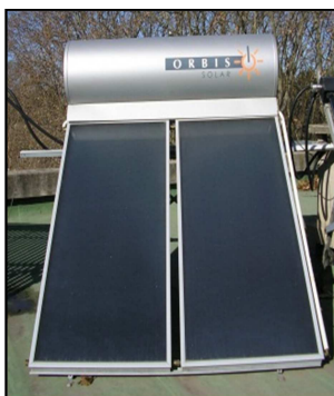
Figura 1: Sistema híbrido eléctrico-solar
