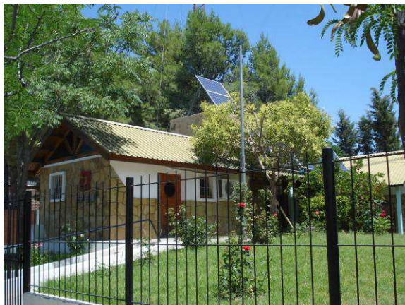
Figura 13: Sistema FV de 2,88 kW p instalado en el EPEN.
